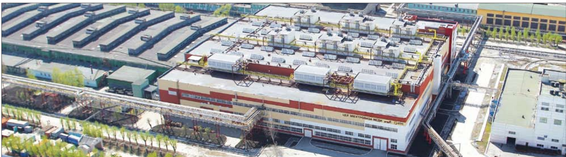
Три года назад здесь был только каркас здания.
